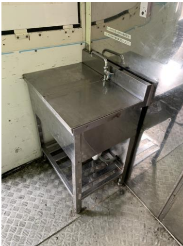
2槽シンク（蓋あり）
