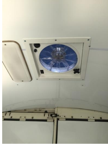
換気扇（車輛前方上部）
