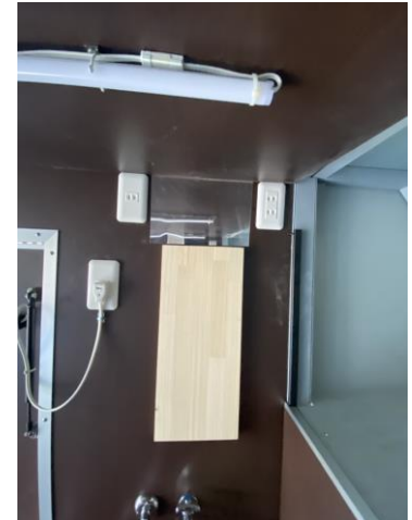
給湯器取付場所
