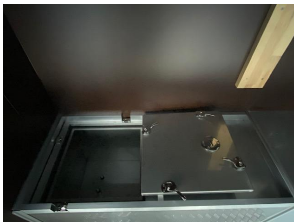
給水タンク (蓋スライド式で作業台利用)
